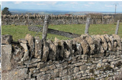
Muro de piedra seca (arenisca) Charolais Brionnais © G. Collin
